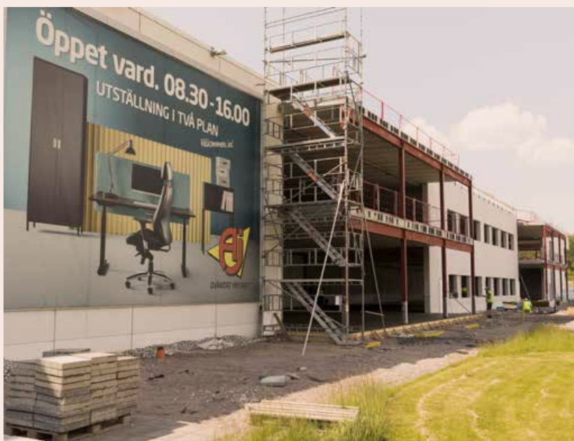
UTBYGGNAD. AJ Produkter är i full färd att fördubbla sin lageryta med 25 000 nya kvadratmeter.
